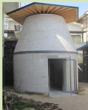
写真3 かきがら入りドーム型積層ブロック構造の納骨堂
