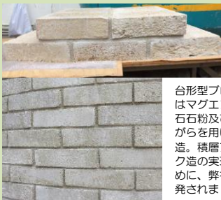
写真3 かきがら入りドーム型積層ブロック構造の納骨堂
